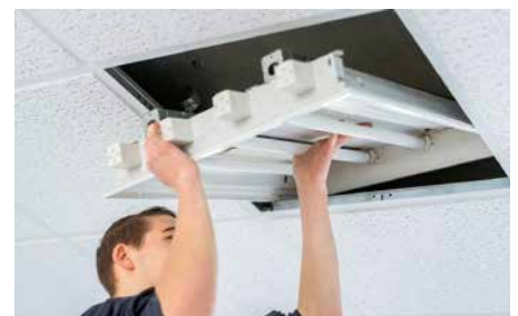
Beleuchtungssanierung: Ihre Möglichkeiten im Überblick!
