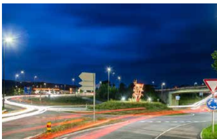
Straßenbeleuchtung: die EN 13201
